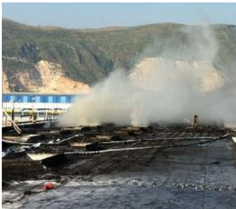
Εικόνα 8.3. Πυρκαγιά σε φωτοβολταϊκό πάρκο
