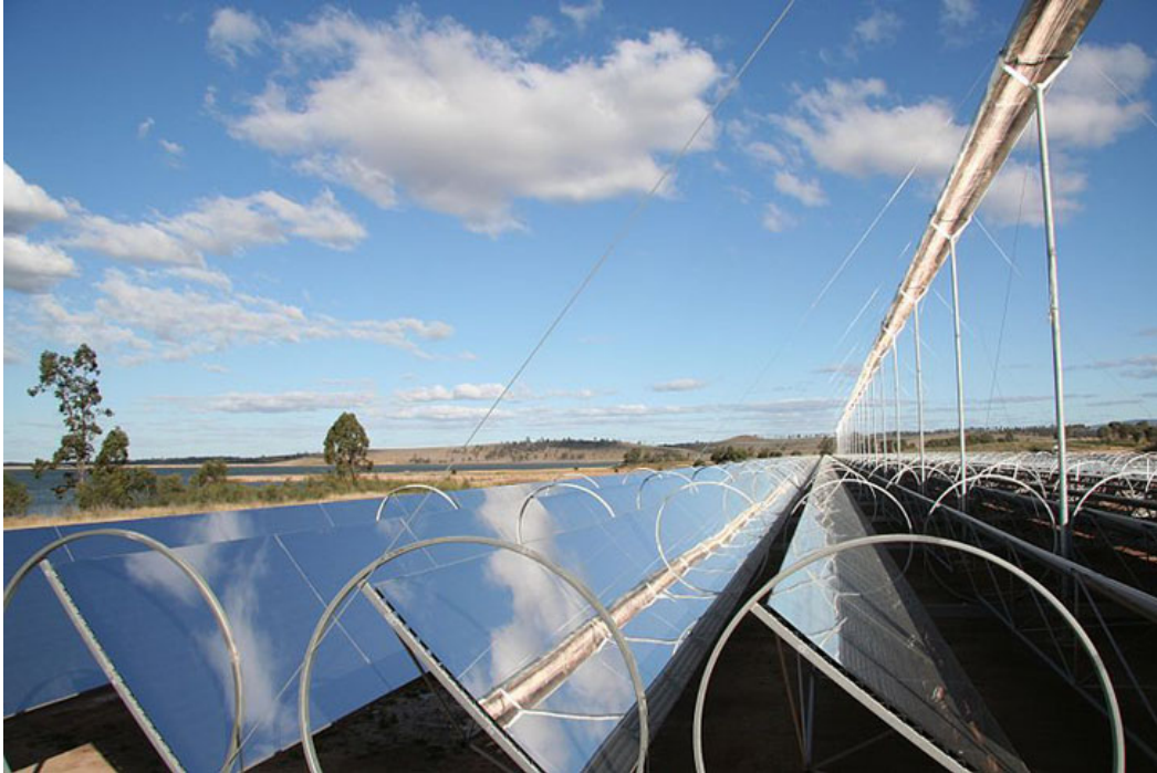
Εικόνα 3.3. Σύστημα Linear Fresnel Reflector
