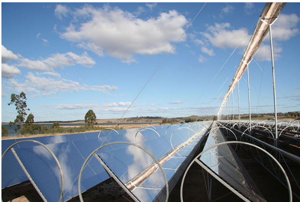
Εικόνα 3.3. Σύστημα Linear Fresnel Reflector
