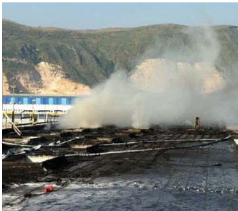
Εικόνα 8.6. Πυρκαγιά σε φωτοβολταϊκό πάρκο
