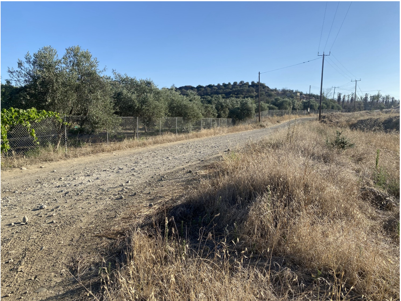
Εικόνα 6.14. Χωμάτινος δρόμος για πρόσβαση στο τεμάχιο μελέτης όπου το τεμάχιο βρίσκεται στα δεξιά,(Aeoliki Ltd, 2023)
