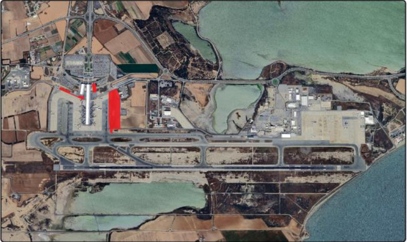
Σχήμα 3- 1: Δορυφορική άποψη του έργου επέκτασης του αεροδρομίου Λάρνακας (Πηγή: BBI-Egis Avia, Δεκέμβριος 2023)
