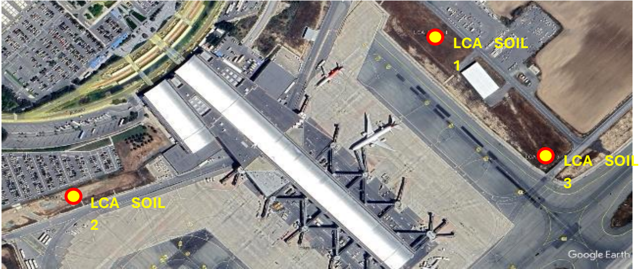
Σχήμα 0-6 Σταθμοί παρακολούθησης του εδάφους (Πηγή: LA Solas Services, 2024)
